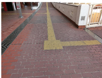
図 25 点状と線状ブロックによる誘導路
