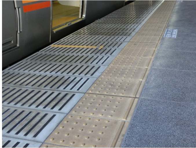
図 29 内方線付き点字ブロック
