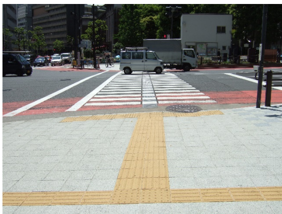
図 28 横断歩道の渡り口における点字ブロックの敷設
