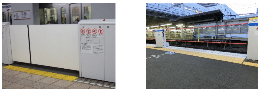
図 51 ホームドア等 （左：可動式ホーム柵、右：ロープ昇降式ホーム柵）
